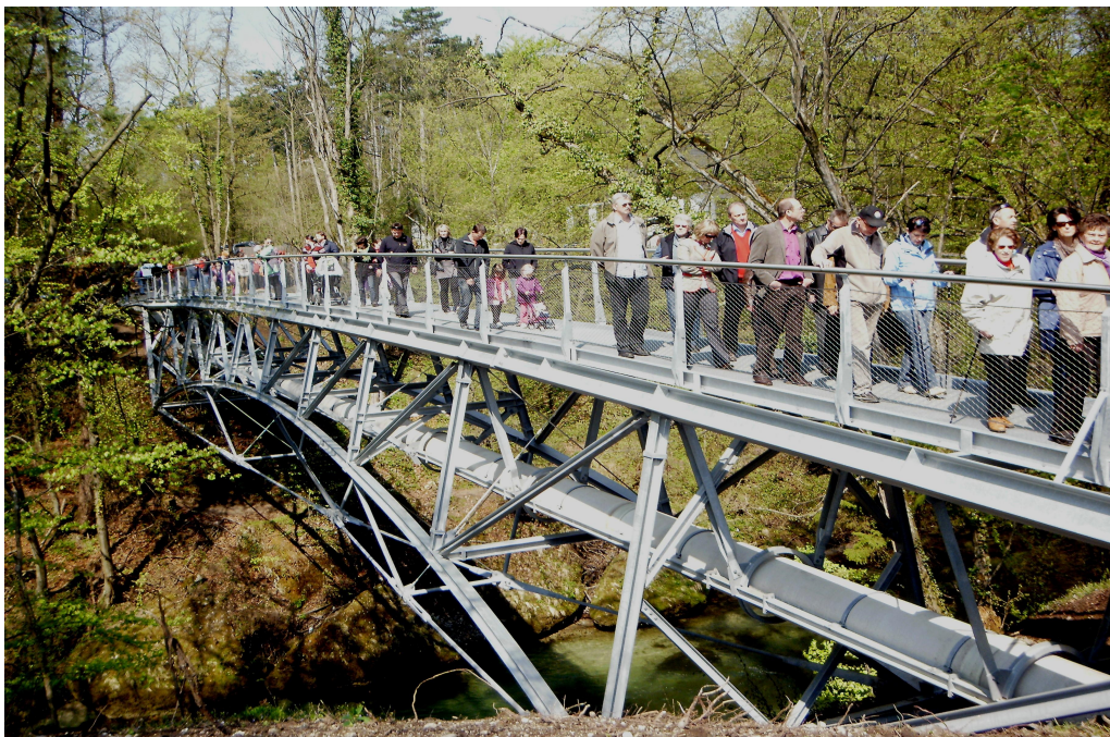
Fertigstellung und Eröffnung der Rohrbrücke Purgstall. Mein Dank gilt vor allem Frau Bürgermeister Marianne Fallmann.
