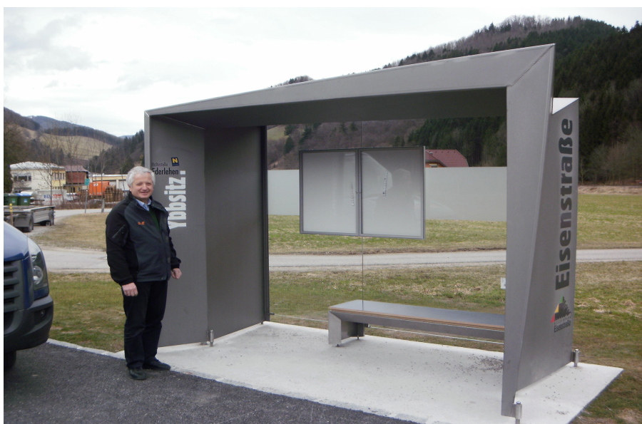
Fertigstellung von 20 Buswartehäusern für die Mostviertellinie, aus 4 mm Niero. ARGE Egger Schiefer Wahler
