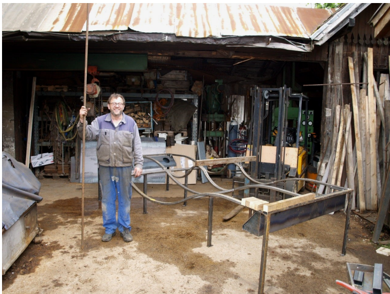
Soundscape im Schillerpark Waidhofen/Ybbs Ausführung der Stahlarbeiten nach den Plänen von Landschaftsplaner Christian Winkler
